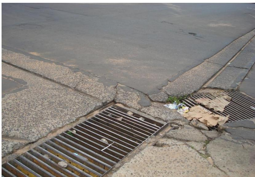
Figura 40 – Galeria pluvial em um dos trechos do transbordamento.
