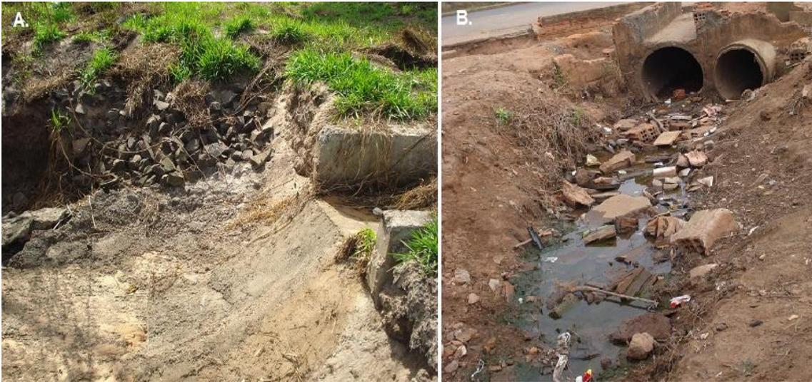
Figura 22 – A. Dissipador inadequado. B. Galeria pluvial que descarrega no curso d'água.
