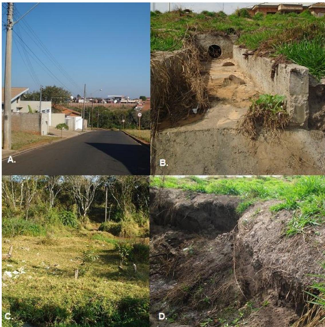
Figura 21 – A. Ruas perpendiculares ao curso d'água. B. Galeria pluvial em superfície. C. Escoamento direto ao córrego. D. Desbarrancamento da vertente.
