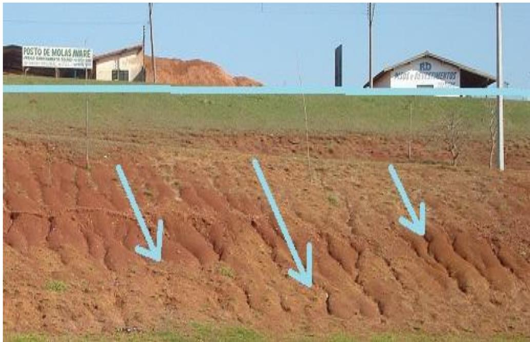
Figura 28 – Esquema do escoamento da água da rodovia para o lago.
